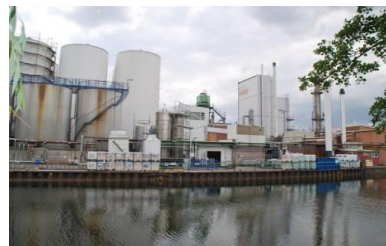
Industrielle Abwärme 400 kWth
